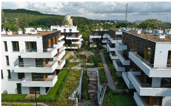
fot. widok z lotu ptaka
